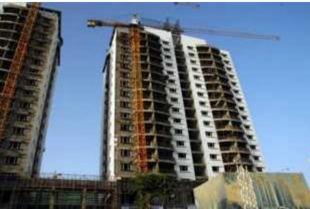
ホテルの近くで建設中のビル
