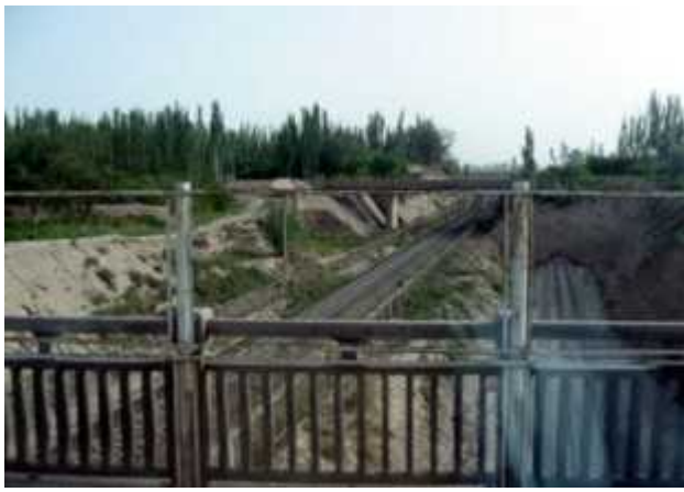
建設中の鉄道(カシュガル—ホータン)
