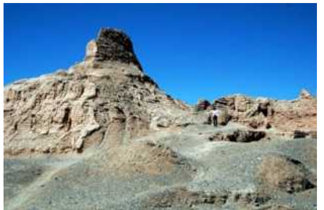
西寺区城壁跡
