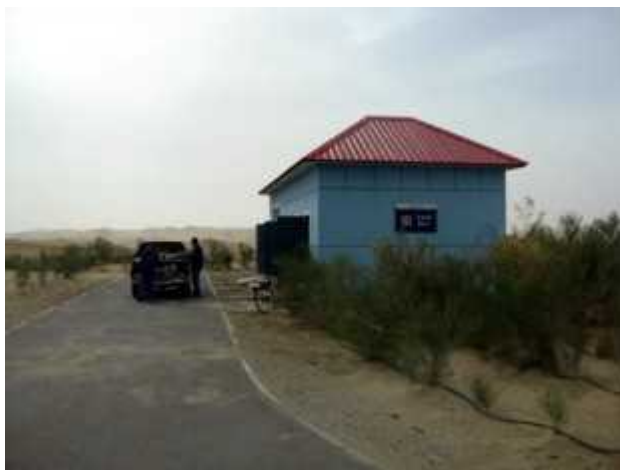
No.93 ポンプ場
